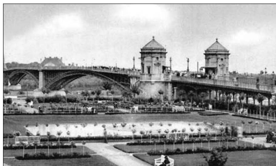
29. ábra: Az új állandó közúti híd Fig. 29 The new permanent vehicular bridge
