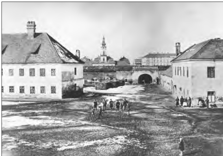
13. ábra: A várudvar a NY-i kapuval, bontás előtt K-ről. Jobbra a hadapród, balra a helyőrségi kaszárnya (1881) Fig. 13 The castle yard with the west gate before the demolition from an east view. There is the cadet on the right and the garrison barrack on the left (1881)
