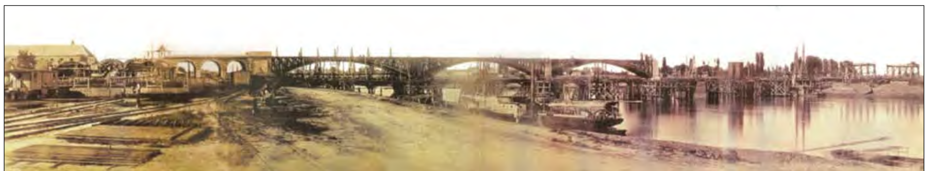
6. ábra: A vasúti híd építés közben, Anton Rohrbach felvétele Fig. 6 The railway bridge under construction (Photo by Anton Rohrbach)
