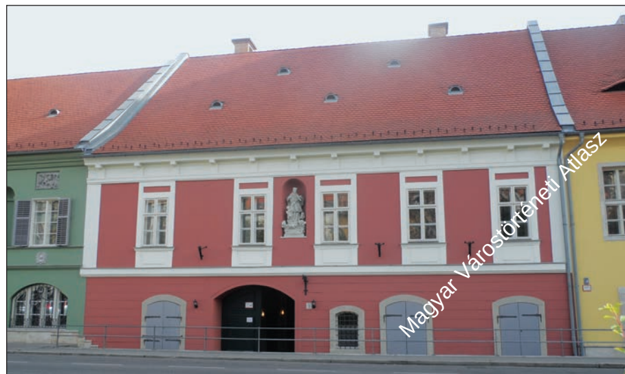
44. ábra. Víziváros, Corvin tér 3. sz. lakóház, 2016 Fig. 44 Víziváros, Corvin Square No. 3, 2016 Fotó / Photo: Simon Katalin
