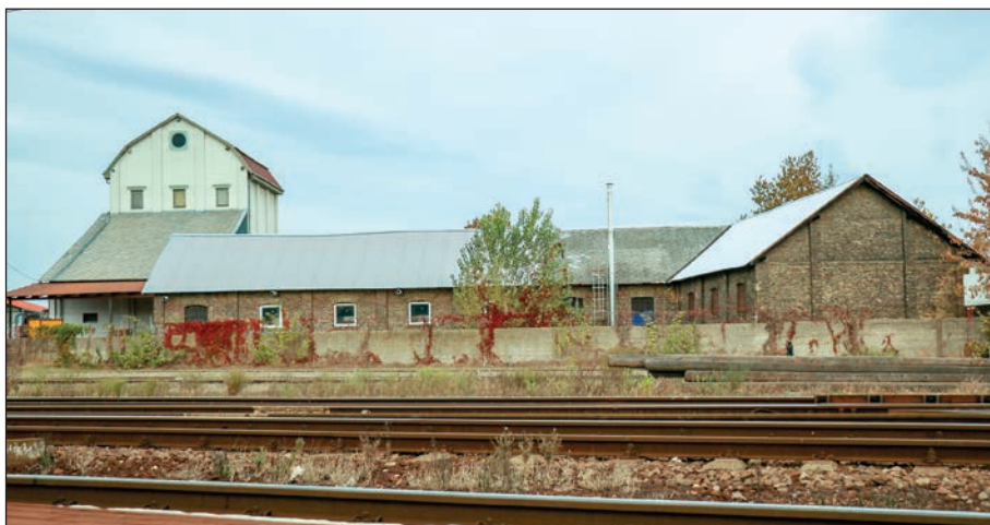
67. ábra. A Szeszfinomító épületei, 2018 Fig. 67 The buildings of the Distillery, 2018 Fotó/Photo: Belényesy Zsófia 2018
