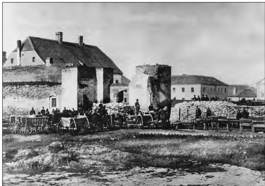
2. ábra: A déli kaputorony DK-ről bontás közben (1881. Fotó: Lauscher Lipót)
