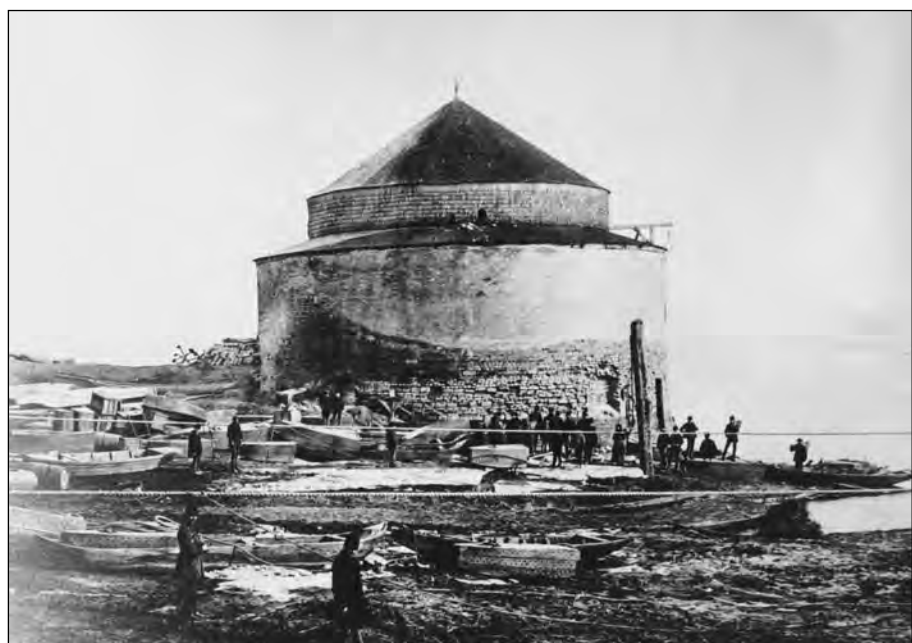
4. ábra: A vízitorony a lebontás előtt (1881. Fotó: Lauscher Lipót)
